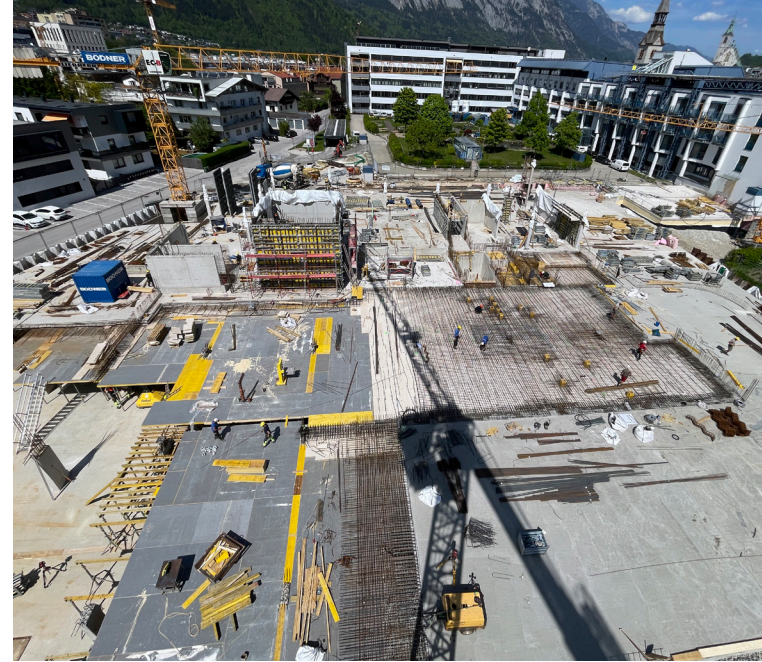
...zur Baustelle: im März 2026 war der Baufortschritt bereits gut ersichtlich.
